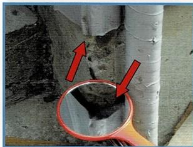
角は特に隙間ができやすい (鏡の中に隙間が見えます)
