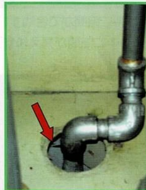
流し台下の排水管まわり
