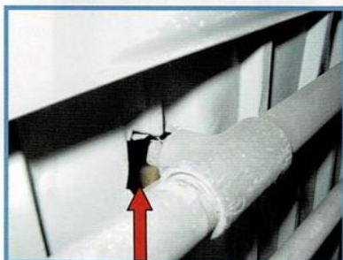
水道管の壁貫通部分
