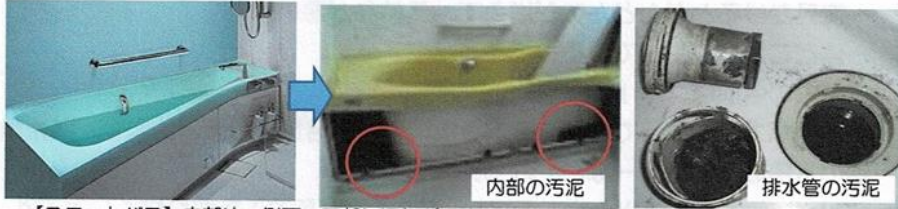
【ユニットバス】内部や、側面、下部に汚れが溜まります。前面のカバーを外し、汚れの状況を確認しましょう。
